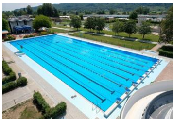
Slika 6: Obnova olimpijskega bazena
