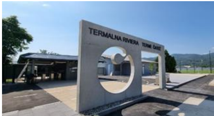
Slika 1: Prenova glavnega vhoda
