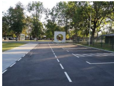
Slika 2: Prenova glavnega vhoda
